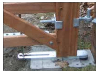
Velegnet til portautomatik. Her vist med nedstøbningsmotor.
