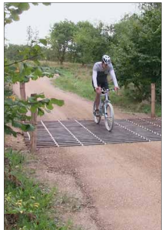
Här med galvaniserade rör
