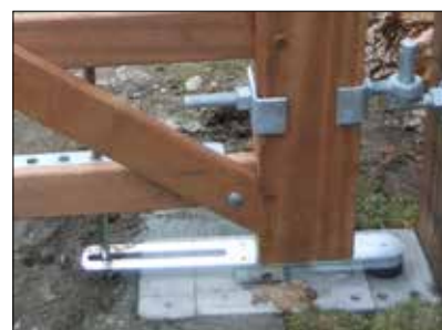
Perfakta för portautomatik. Här visade med nedgjutningsmotor.
