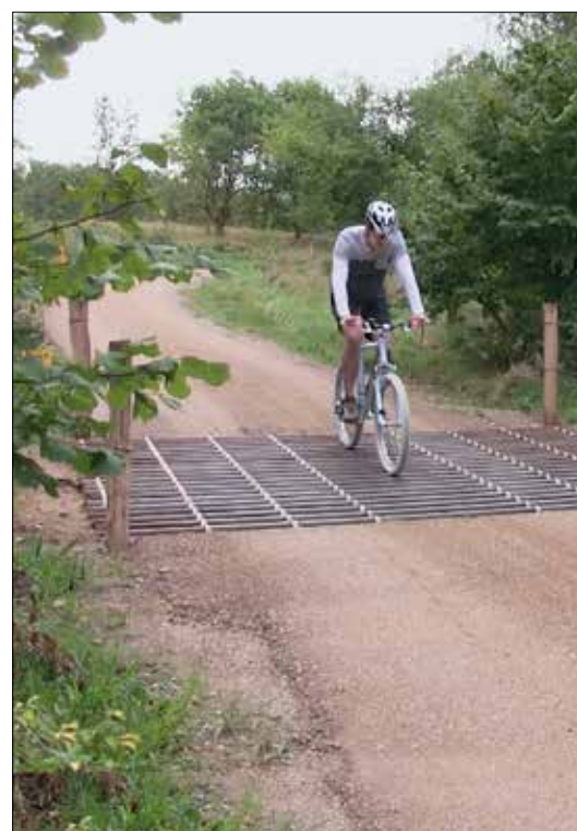
Færisten her er med galvaniserede rør
